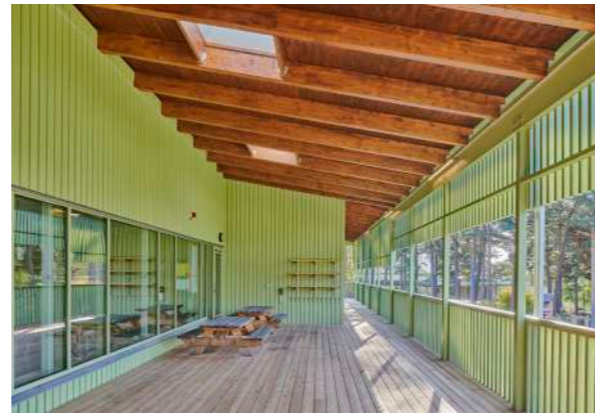
Exempel på loggia med ribbverk som bildar zonen mellan ute och inne. Träffen förskola, LLP Arkitektkontor.
