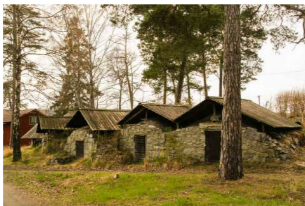
Jordkällare byggda av överbliven sprängsten
