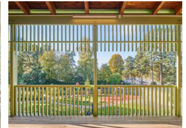
Ribbverk som skärmar av mot solen samt skapar en vacker skuggverkan som ändrar husets uttryck under dagen.
