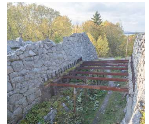
Stenmurar vid stenbrottet
