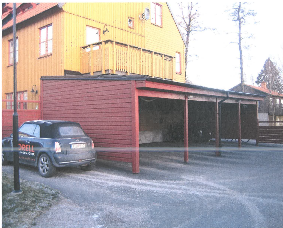
Exempel på miljö med garagegård innehållande carport
